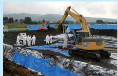
平成22年4月 口蹄疫発生時の埋却作業
