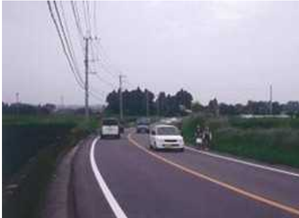
県道宮崎田野線 法光坊工区
