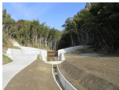
北伊倉1谷川（令和6年度完成）
