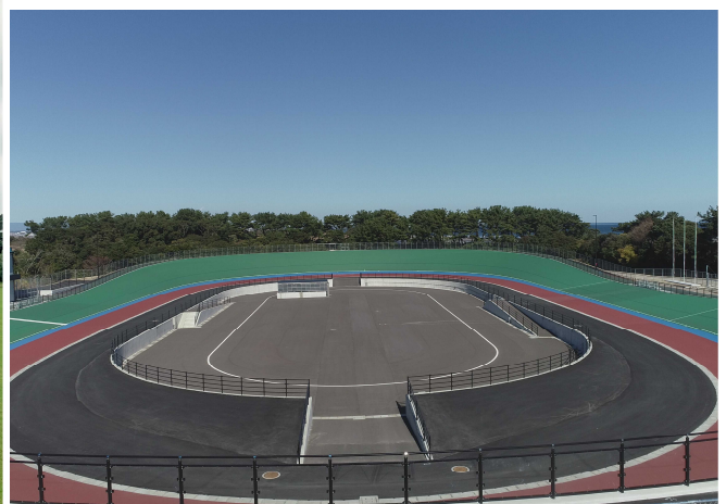
自転車競技場整備工事完成(令和7年度完成)
