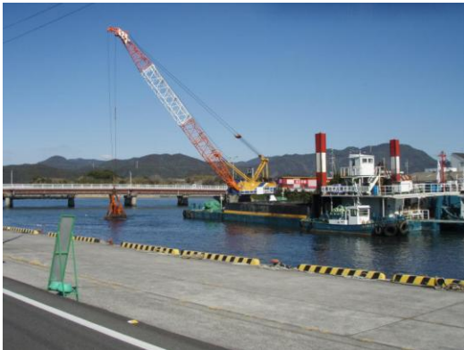
福島港（泊地浚渫状況）
