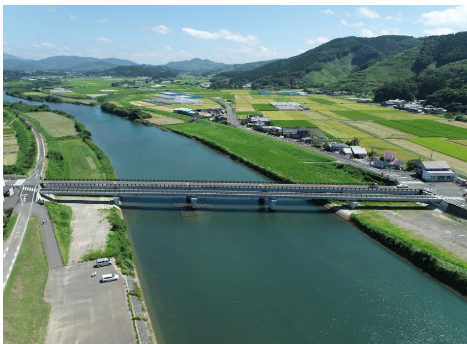
令和7年度完成 一般国道448号 蔵元橋側道橋
