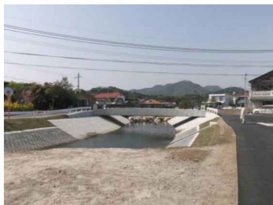
市道ひきじ橋付近
