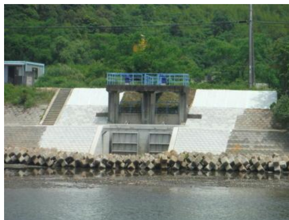
福島川 7号樋門
