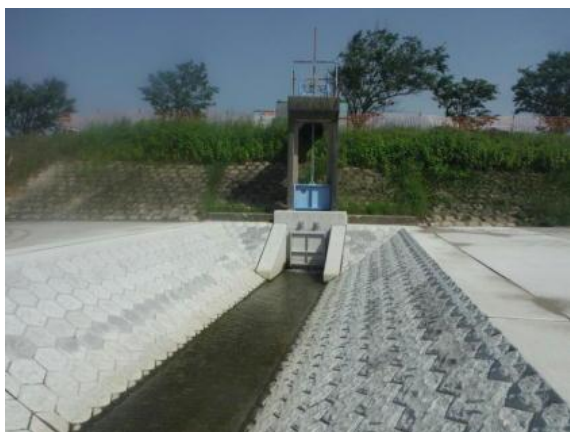
福島川 寺園樋門
