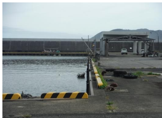
第5物揚げ場（耐震補強）
