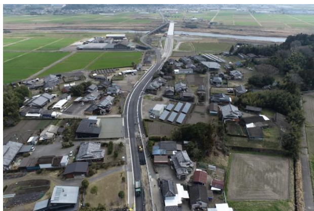
高城山田線 道路整備
