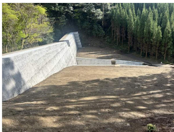
柳野谷川砂防堰堤（R8.3）
