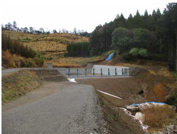
東田野谷川砂防堰堤（R8.3）※事業中
