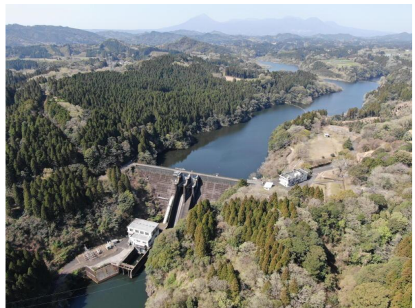
(岩瀬ダム全景)
