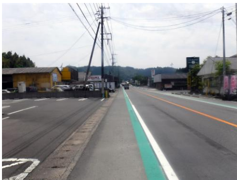
歩道工事(国道 221 号麓工区 着手前)
