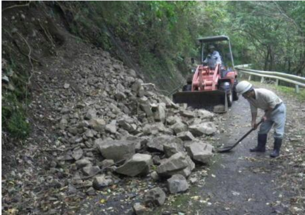
<道路応急対策状況>
