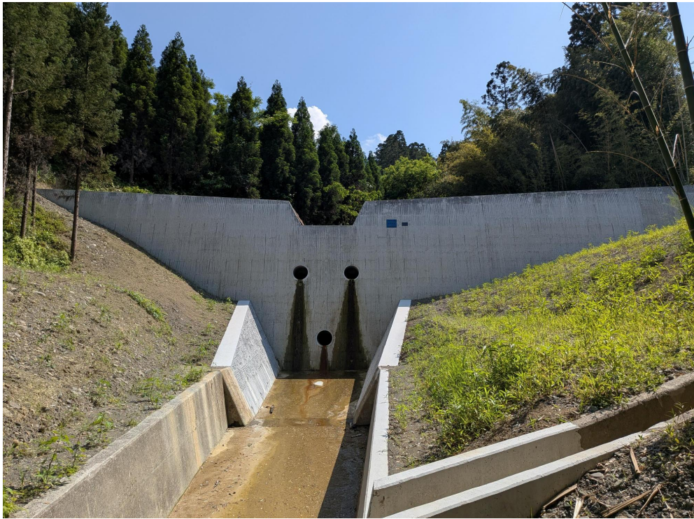
〈綾町 城平川 砂防堰堤〉
