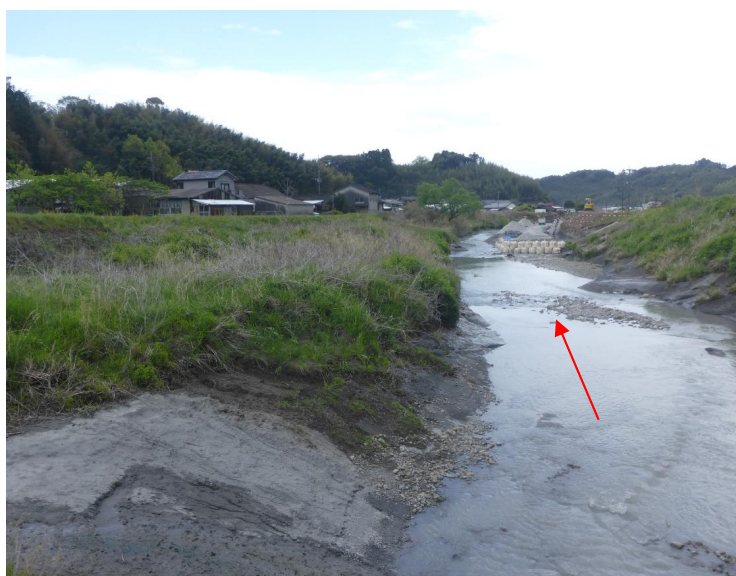
河 道 の 拡 幅 〈深年川施工前(岩下向橋下流)〉
