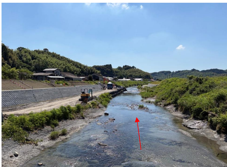
施工中（岩下向橋下流）
