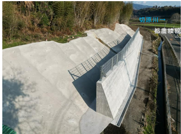
急傾斜事業 城山－２地区（木城町） （令和７年度事業完了）
