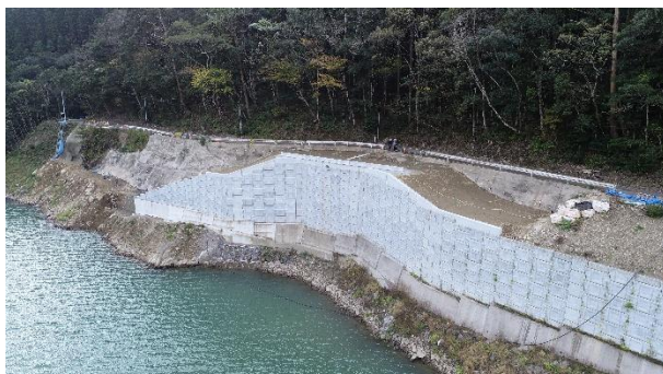
(東郷西都線 松尾ダム工区 施工中)
