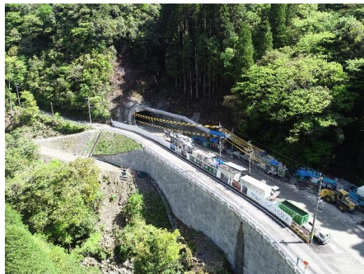
R8年4月（2号トンネル）
