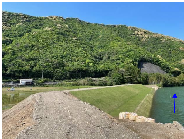
丸口地区（築堤工事）
