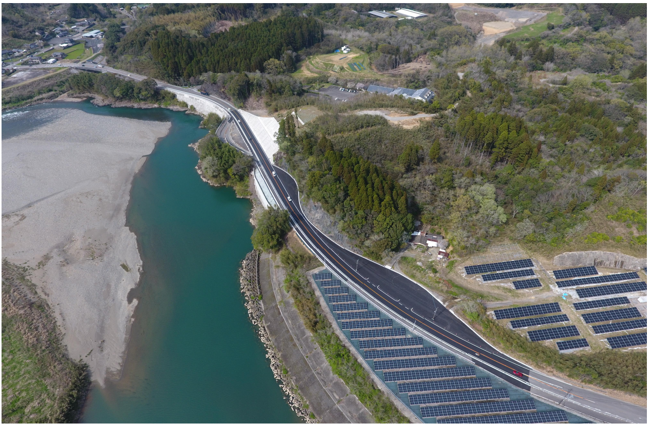
国道327号（切瀬工区）（令和8年4月撮影）
