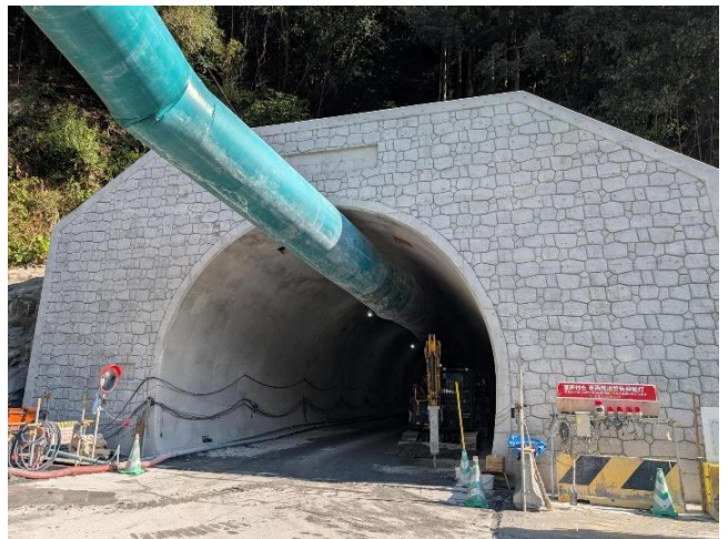
R7年11月（３号トンネル）
