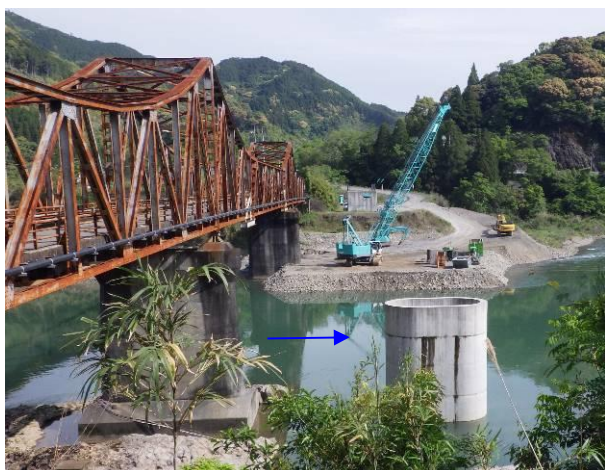
福瀬大橋（橋梁架替事業）
