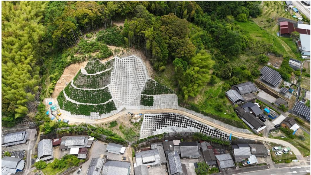
中田谷川 1 令和 8 年 5 月 施工中
