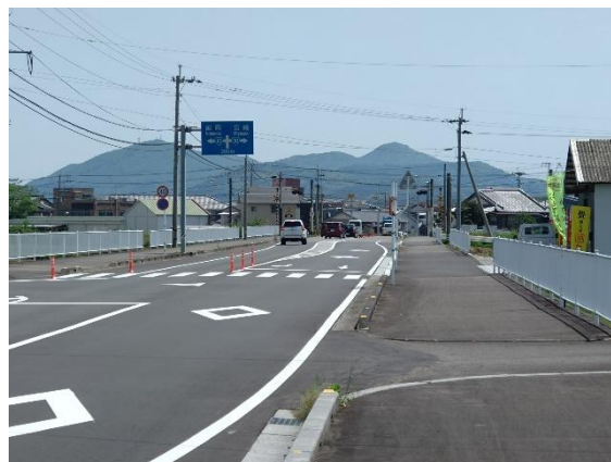
国道 388 号 上町工区
