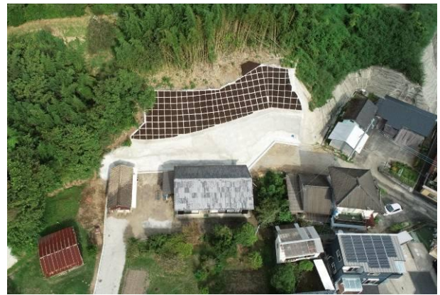
令和 7 年 1 0 月 完成
