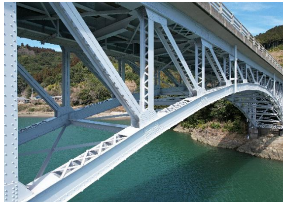
橋梁補修（中野原美々津線美々津橋）
