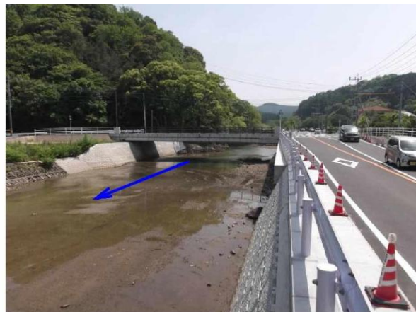
飛川橋(橋梁完成)
