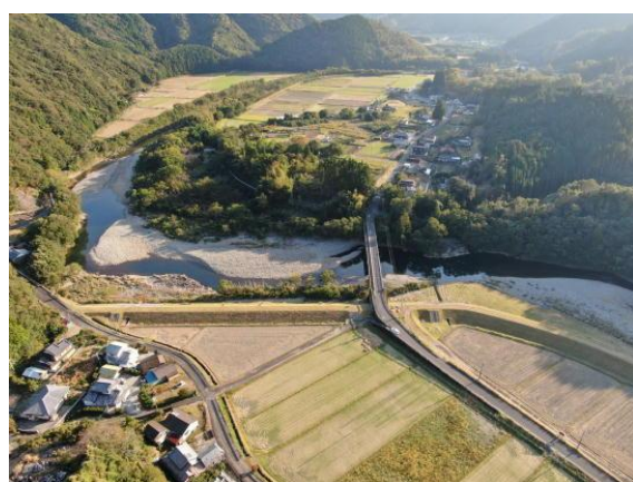
整備状況（妙工区・桑平橋工区）
