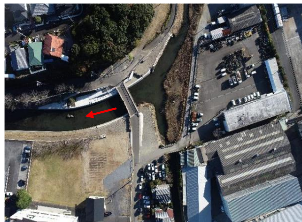
櫛津1号橋付近(R6.8完成)
