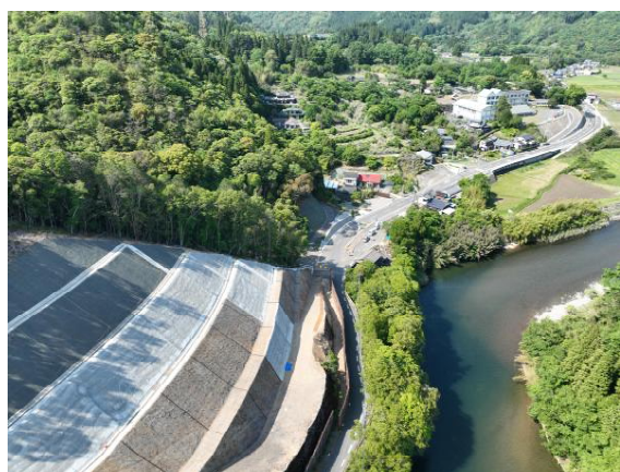
道路状況（黒岩工区）
