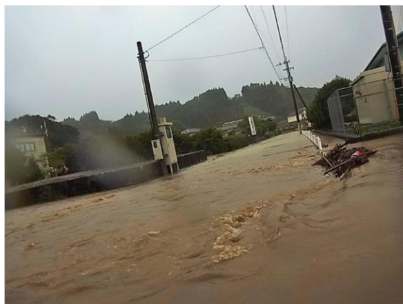
平成26年の浸水状況
