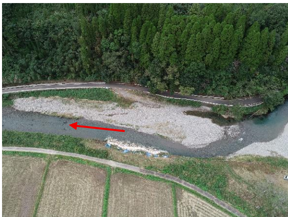
掘削・状況(曾木川：北方町曾木地区)
