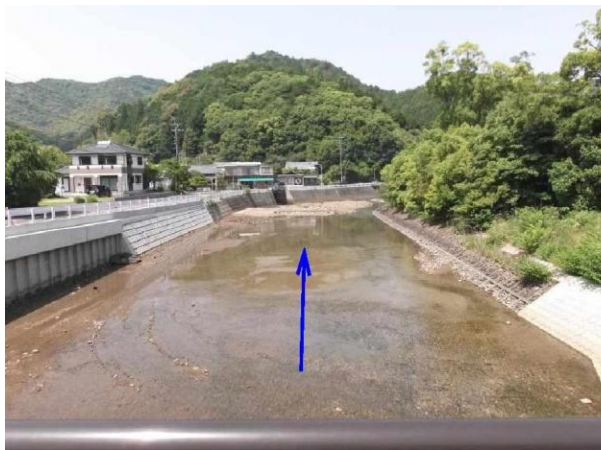
飛川橋下流(護岸完成)
