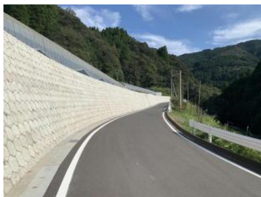
板上曽木線整備状況（三槌工区）
