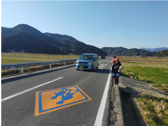
沖田工区道路状況
