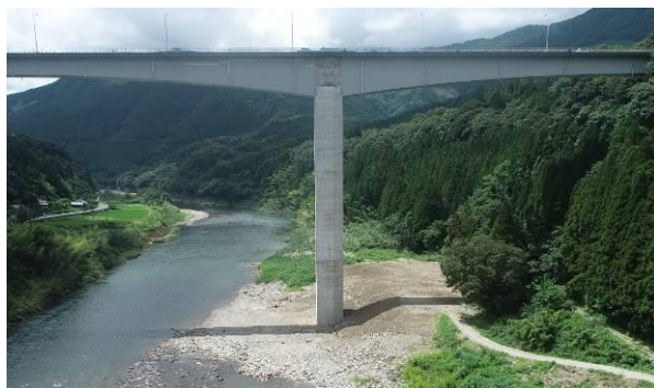
P1 橋脚補強工事
