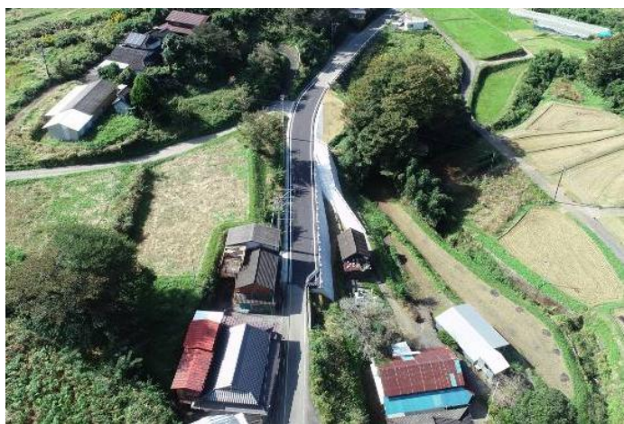
道路改良事業（下野鹿狩戸線下野東工区）
