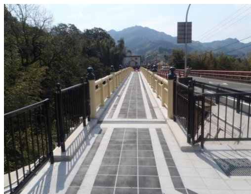
県道下野鹿狩戸線 歩道整備
