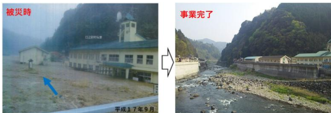
土地利用一体型水防災事業 日之影町大字七折 (新日之影地区)
