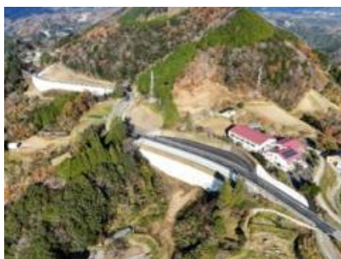
土生工区開通 (R6. 12. 13)
