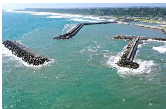
北沖防波堤(着手前)
