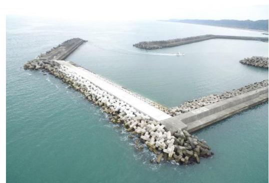
北沖防波堤(完成)
