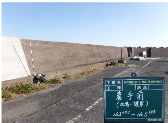
北第一護岸(着手前)
