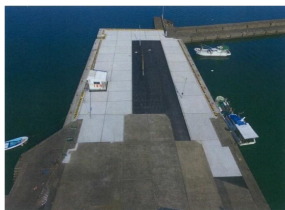
第2物揚場(完成)
