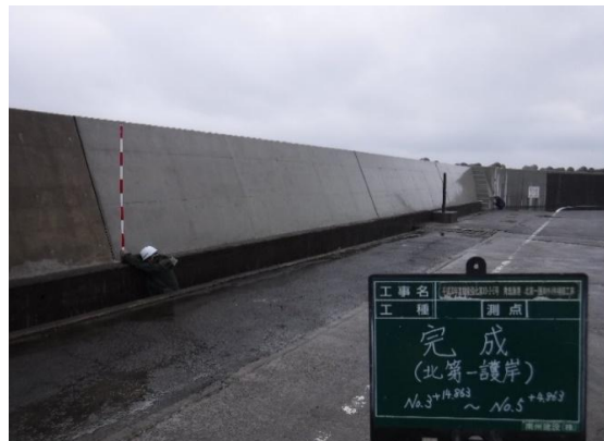
北第一護岸(完成)
