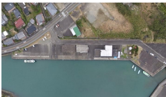
－2m物揚場(着手前)
