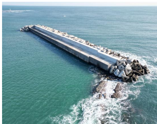
沖防波堤(完成)
