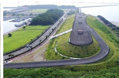
津波避難施設
