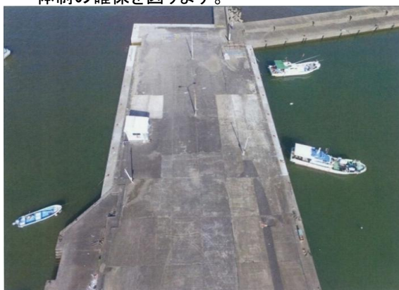
第2物揚場(着手前)
