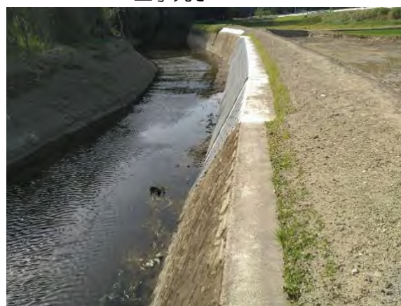
RO6災 隅谷川 護岸被災 工事完了
