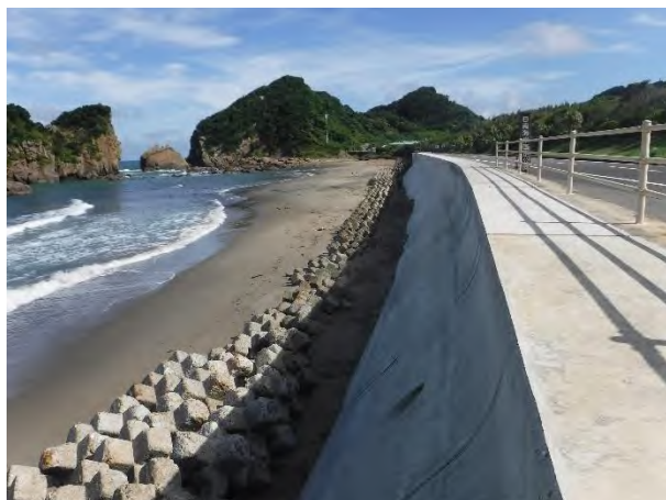
古奥海岸（護岸工）R5完
