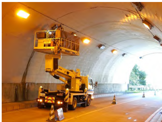
トンネル点検（国道 222 号）
