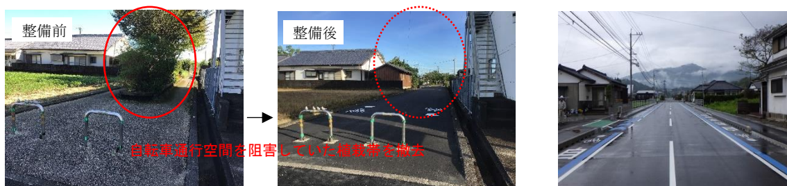
①大規模自転車道の改修（宮崎佐土原西都自転車道）
