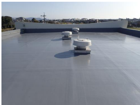
屋上FRP防水工事
