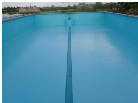
水槽内面FRP防食工事
