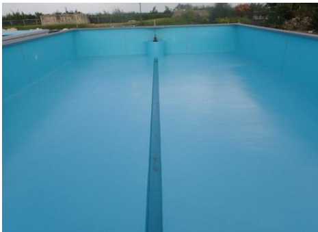
水槽内面FRP防食工事
