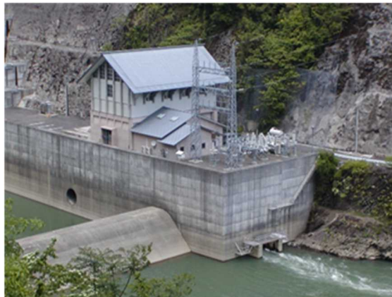
田代八重発電所
