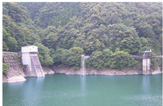
綾北ダム選択取水設備（写真左）
