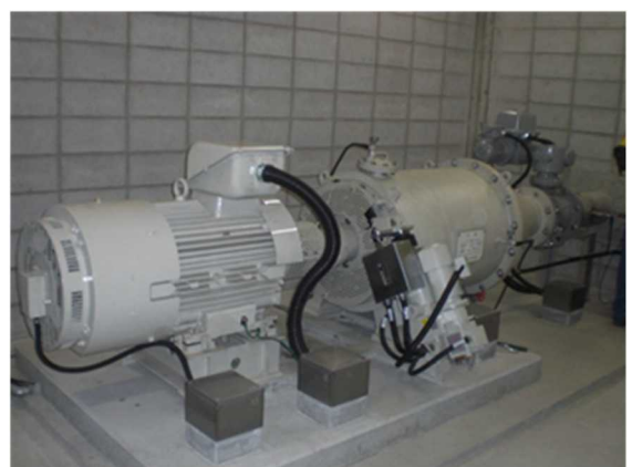
祝子第二発電所水車発電機
