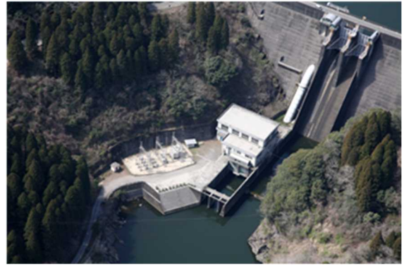
岩瀬川発電所
