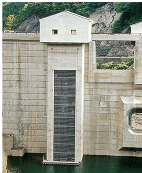
田代八重ダム選択取水設備
