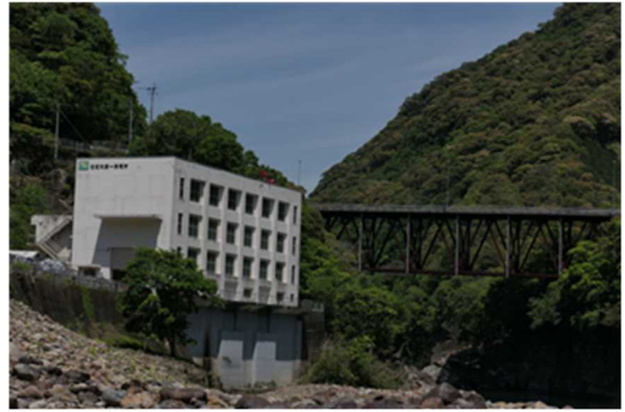
石河内第一発電所
