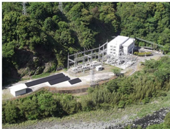
綾第二発電所
