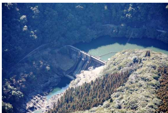
古賀根橋ダム
