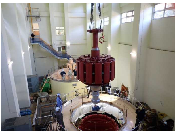
更新した発電機（回転子）の据付状況
