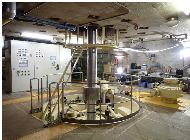
水車室機器の更新状況
