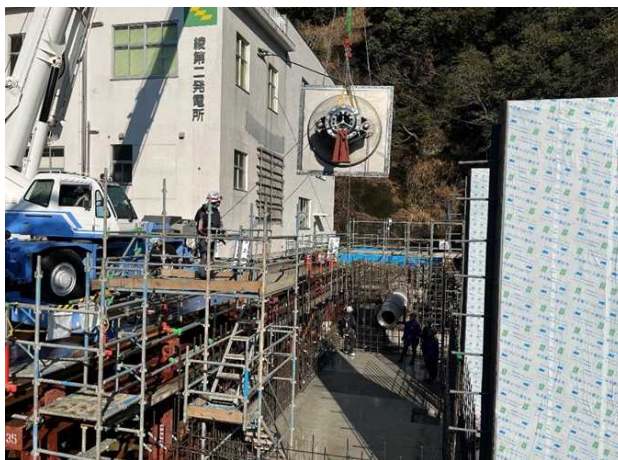
代替放流設備の据付状況
