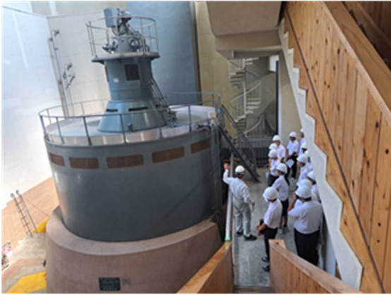
岩瀬川発電所
