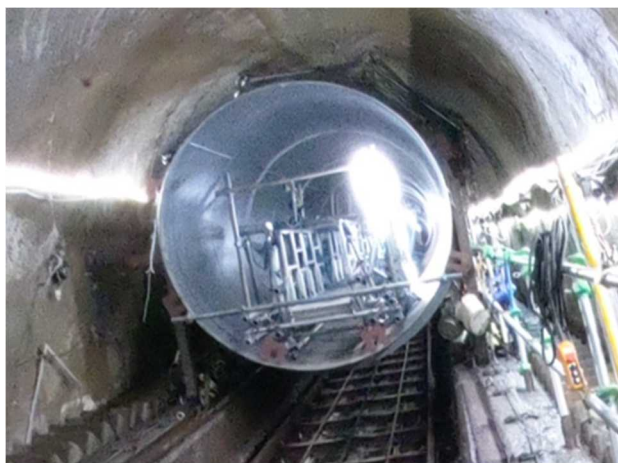
水圧鉄管の据付状況
