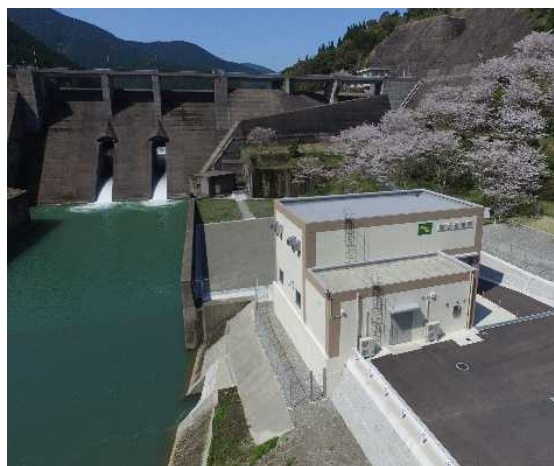
酒谷発電所と日南ダム
