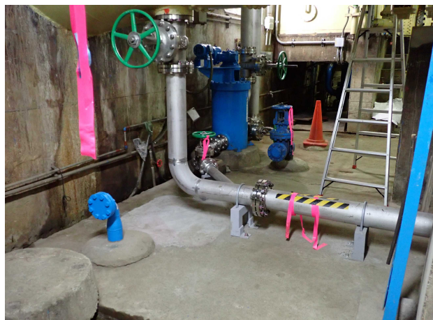
給排水配管の更新状況
