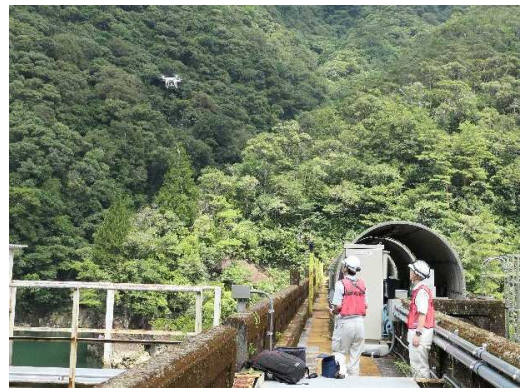
ドローンによる調査
