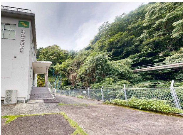
代替放流設備の着手前
