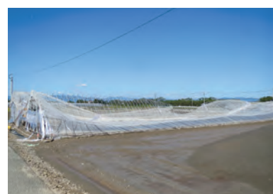
ビニールハウスの倒壊 (H30台風24号)
