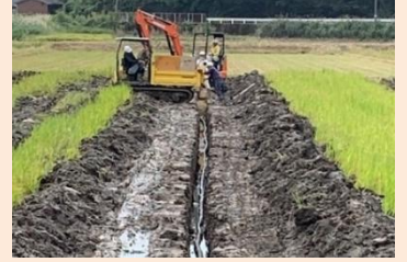
水田の暗渠排水整備
