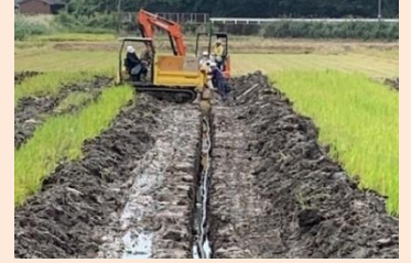
水田の暗渠排水整備
