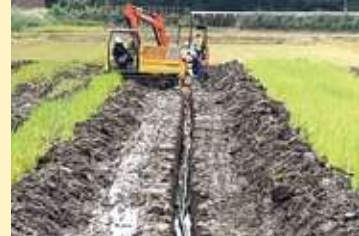
水田の暗渠排水整備
