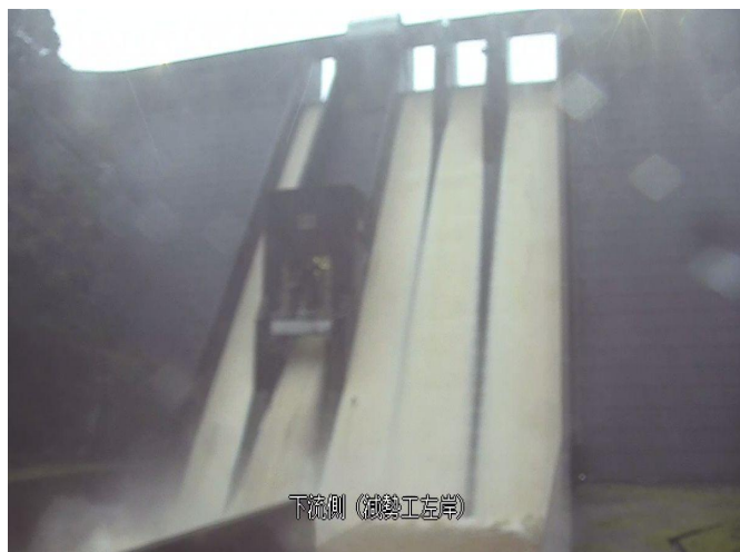
延岡市：祝子ダム 令和4年台風14号 洪水吐き越流の様子
