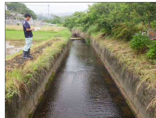
▲点検状況（塩見川水系東川）
