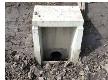
落水口の整備
