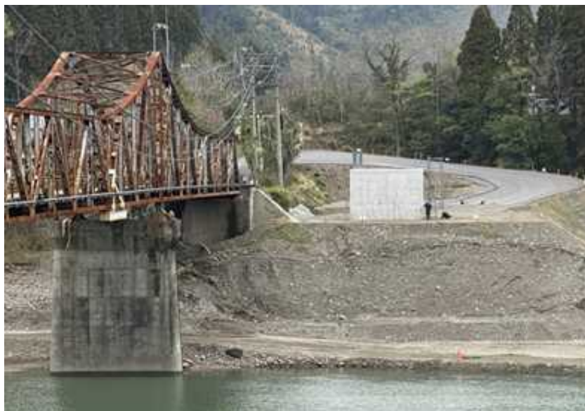
福瀬大橋橋梁架替
