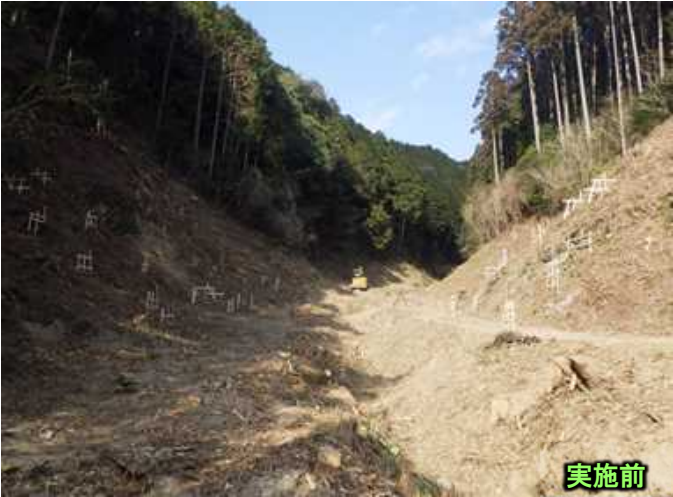
西川内谷川 砂防堰堤の整備
