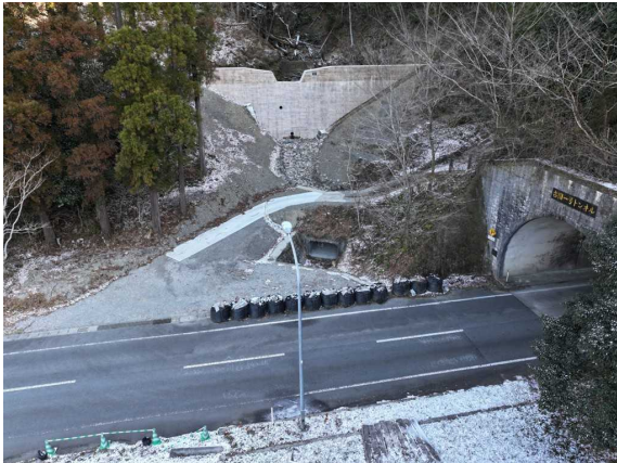
刑部谷 治山ダム工（諸塚村）
