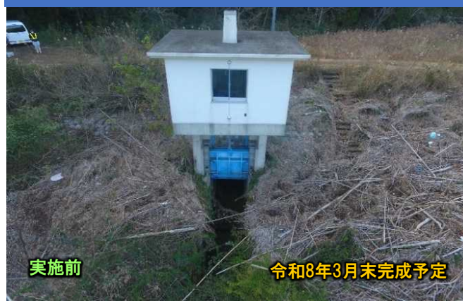
五十鈴川6号樋門(門川町)
