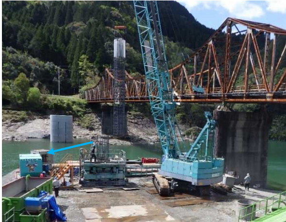
日向市 福瀬大橋橋梁架替
