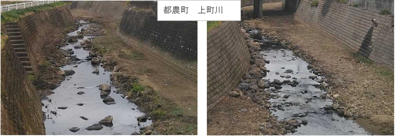
滯筋を蛇行させ、瀬と淵を確保 飛び石を配置し、流れに変化をつけた
