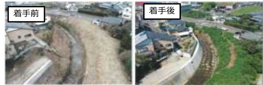
整備完了写真・整備イメージ
