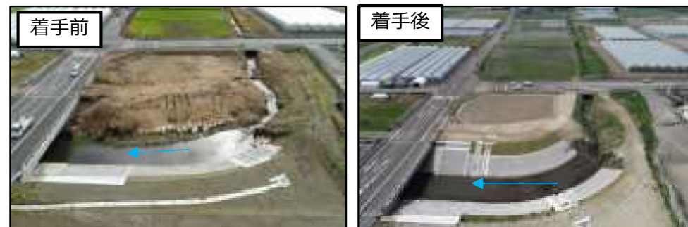
整備完了写真・整備イメージ
