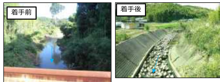
整備完了写真・整備イメージ
