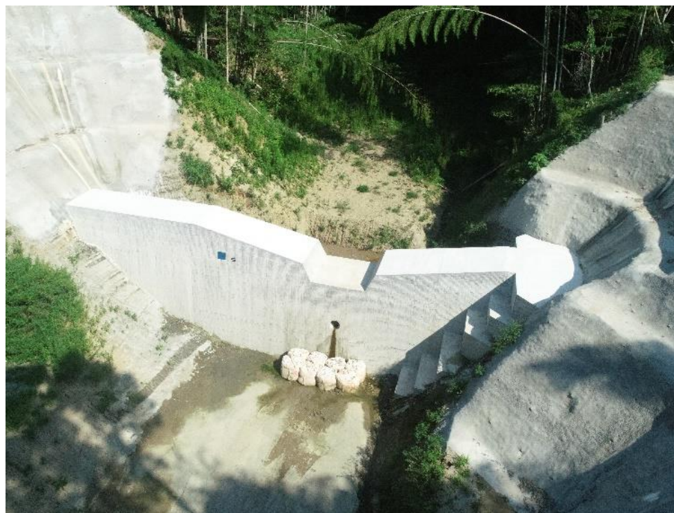
伊倉谷川 1 砂防堰堤
