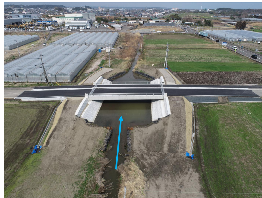
完成 (下ノ山橋)
