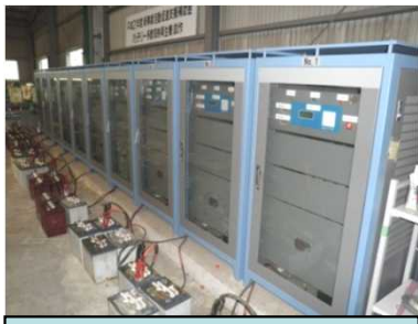
「関谷式再生機」により充電
