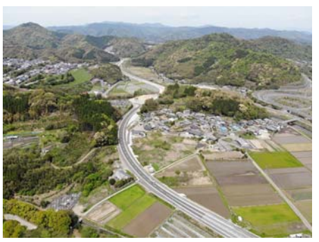
国道327号 永田工区
