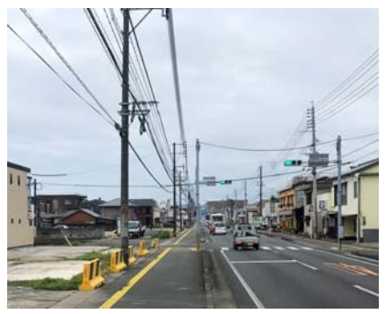
安賀多通線(稲葉崎平原線) 構口工区
