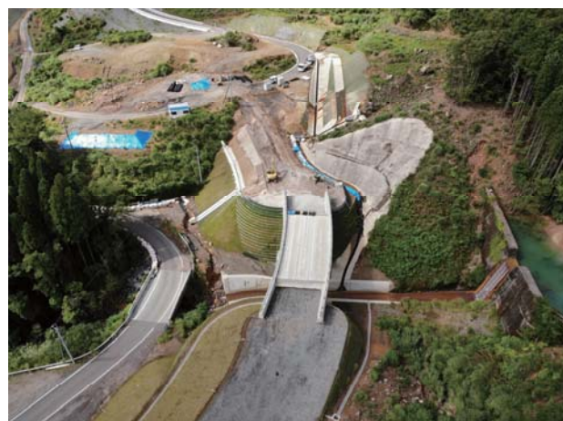
国道447号 真幸工区
