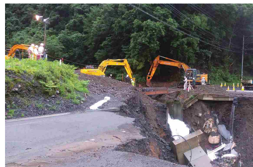
豪雨で崩壊した道路の復旧工事
