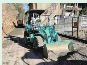
重機で集中して作業をしていると、あっという間に時間が過ぎていきます。
