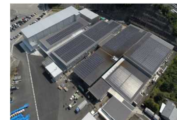
工場屋上の太陽光パネル
