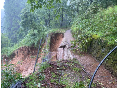
水路の崩壊（高千穂町）
