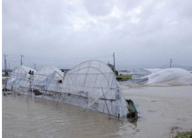
園芸ハウスの倒壊、冠水（西都市）
