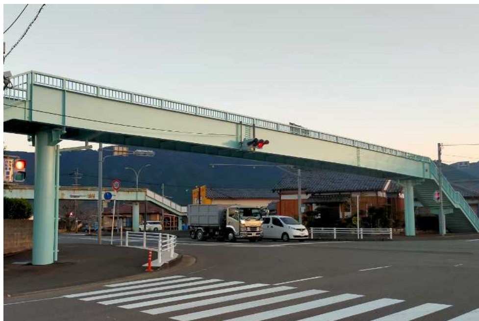
国道269号 寺町1号横断歩道橋
