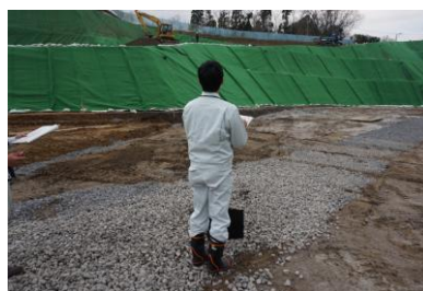
産業廃棄物処分場の検査
