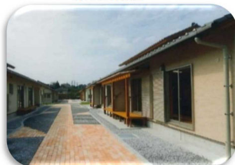
▲県営ひかりヶ丘 C 団地（宮崎市） （木造、子育て世帯向け）
