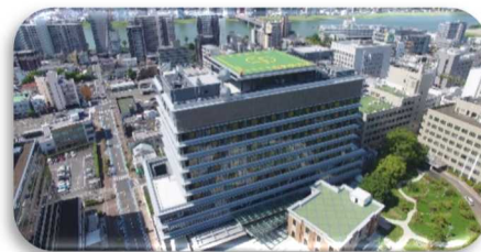
▲県防災庁舎 (R2.8完成 宮崎市)
