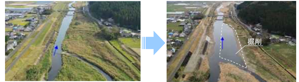
大淀川支川本庄川で実施した河道掘削事例
