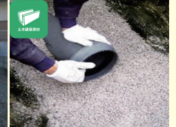
水道管の保護砂
