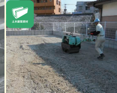
アスファルト舗装の路盤材
