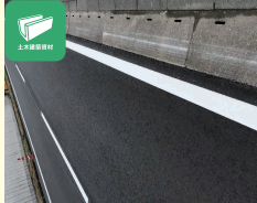
アスファルト舗装材として
