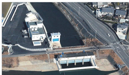
・蛇谷川排水機場
