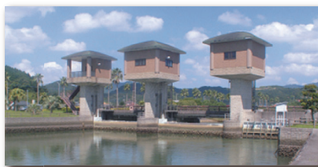
・庄手川防潮堰
