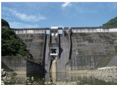
●設備更新 (放流設備改良工事)
