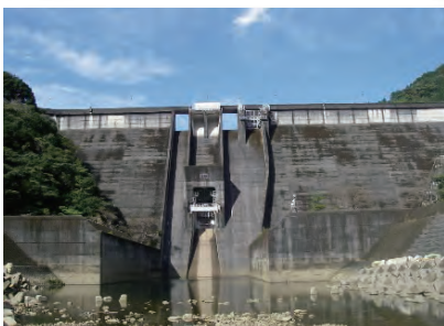
●設備更新 (放流設備改良工事)
