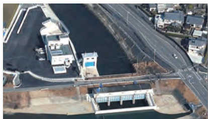
・蛇谷川排水機場
