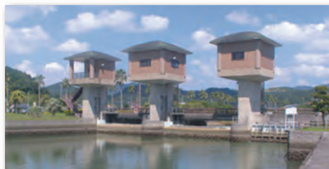
・庄手川防潮堰
