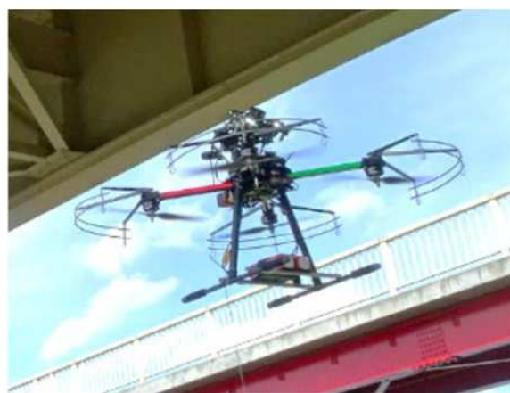
ドローンによる道路施設損傷把握
