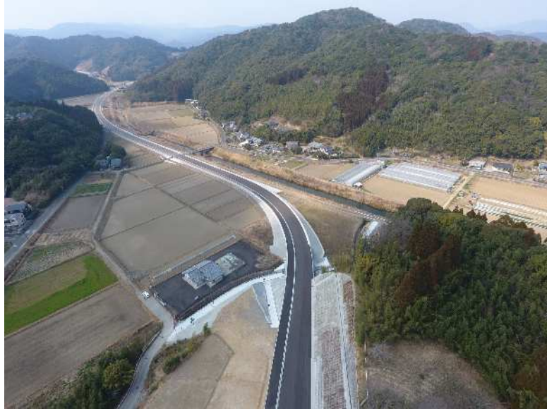
国道327号 永田工区
