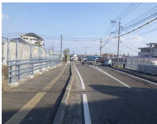
(一) 土々呂日向線 橋梁補修
