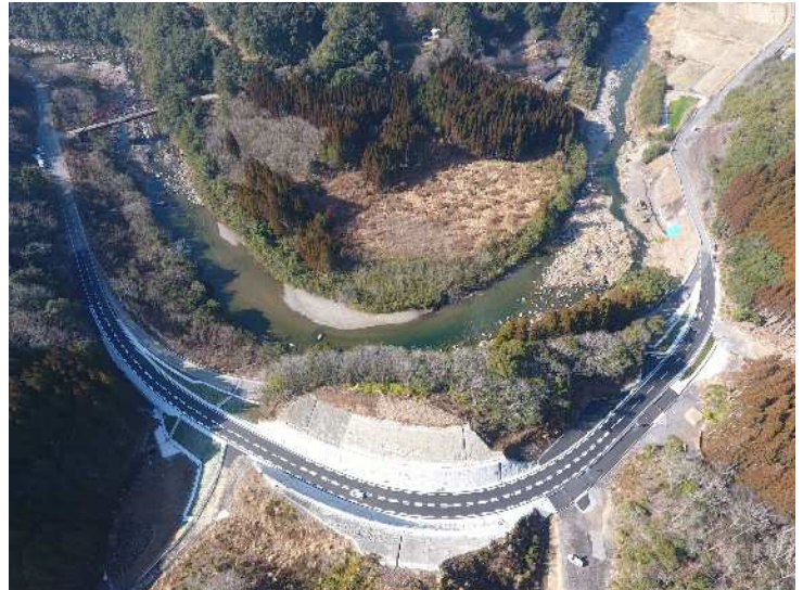
国道388号 舟方工区
