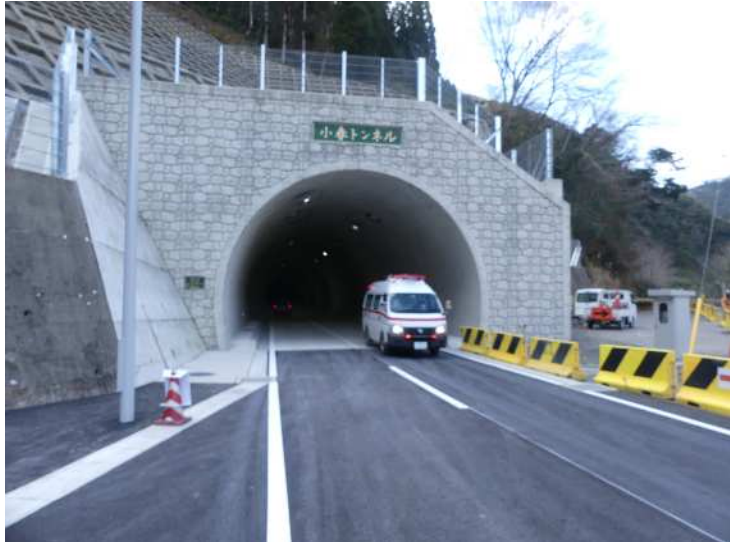
国道219号 小春工区
