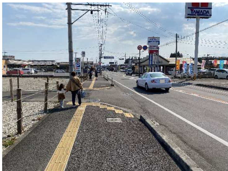
(主) 高鍋高岡線 歩道整備
