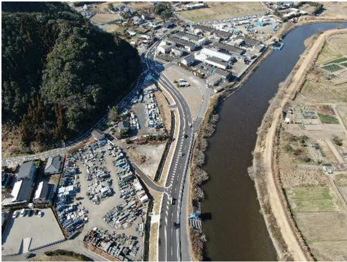
県道北方土々呂線 石田工区
