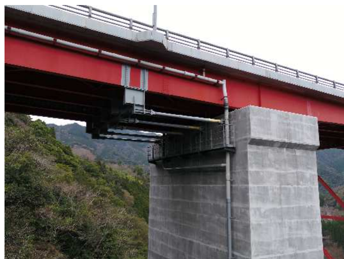
国道218号 干支大橋
