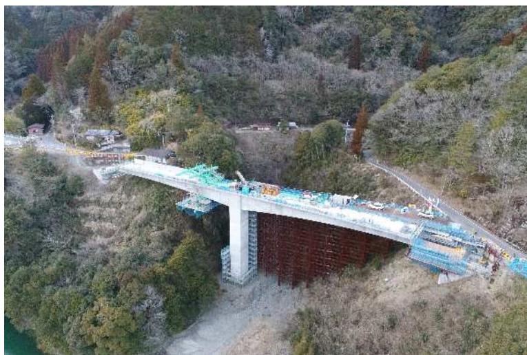
国道327号 佐土の谷工区
