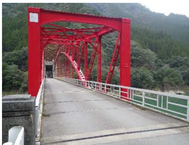
(主) 東郷西都線 橋梁補修
