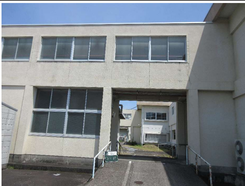
14-1棟 (廊下部分) 南側外観 外壁・ピロティ見上げ
