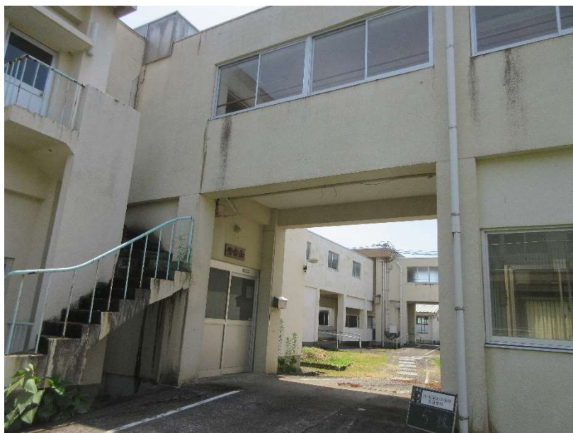
5 棟 北側外観 外壁・ピロティ見上げ
