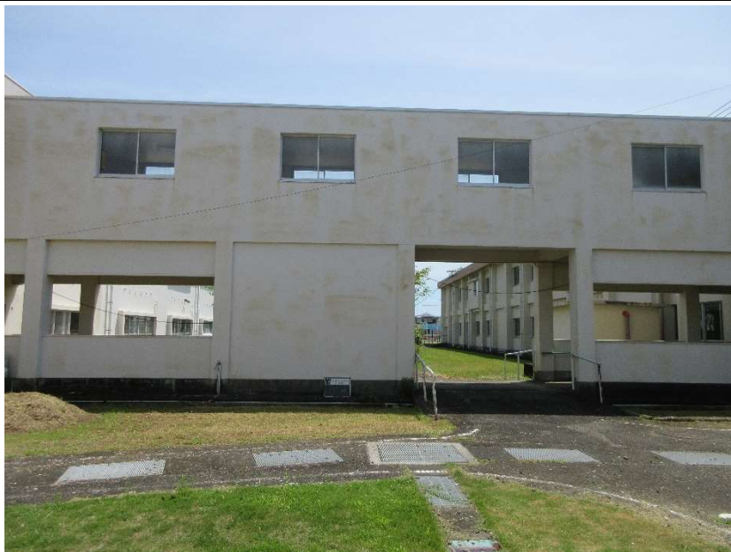
17棟 西側外観 外壁・ピロティ見上げ
