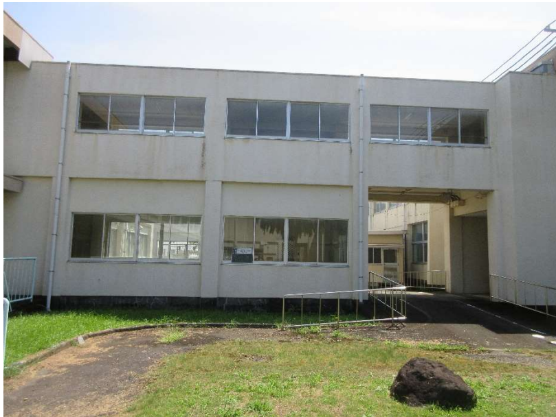
7-1 棟 西側外観 外壁・ピロティ見上げ
