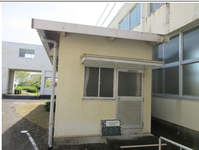
19-2棟 西側外観 外壁・玄関庇見上げ
