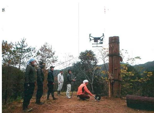
ドローンによるリードロープ運搬
