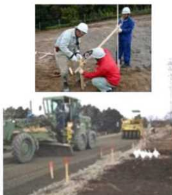
（丁張りによる施工）
