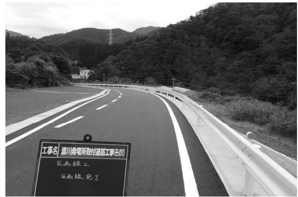
道路新設工事
